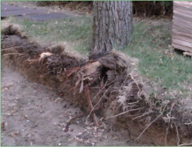
Figura 13.1. Construcción de un camino sin respetar la ZPR.
