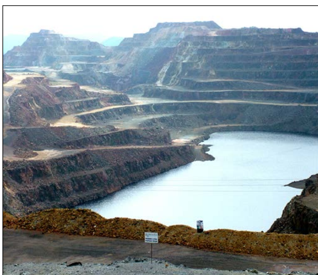
Instalaciones de Cerro Colorado. Actualmente se encuentran inundadas y paralizada la actividad minera
