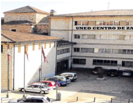
Edificio en Zamora que alberga la UNED.
